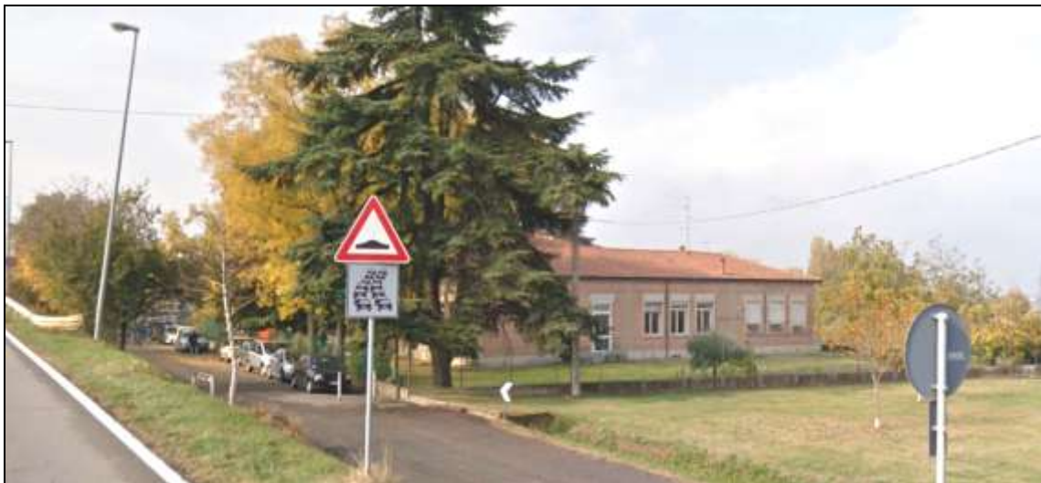
IMM06_foto lato Est, scatto da via Matteotti.
