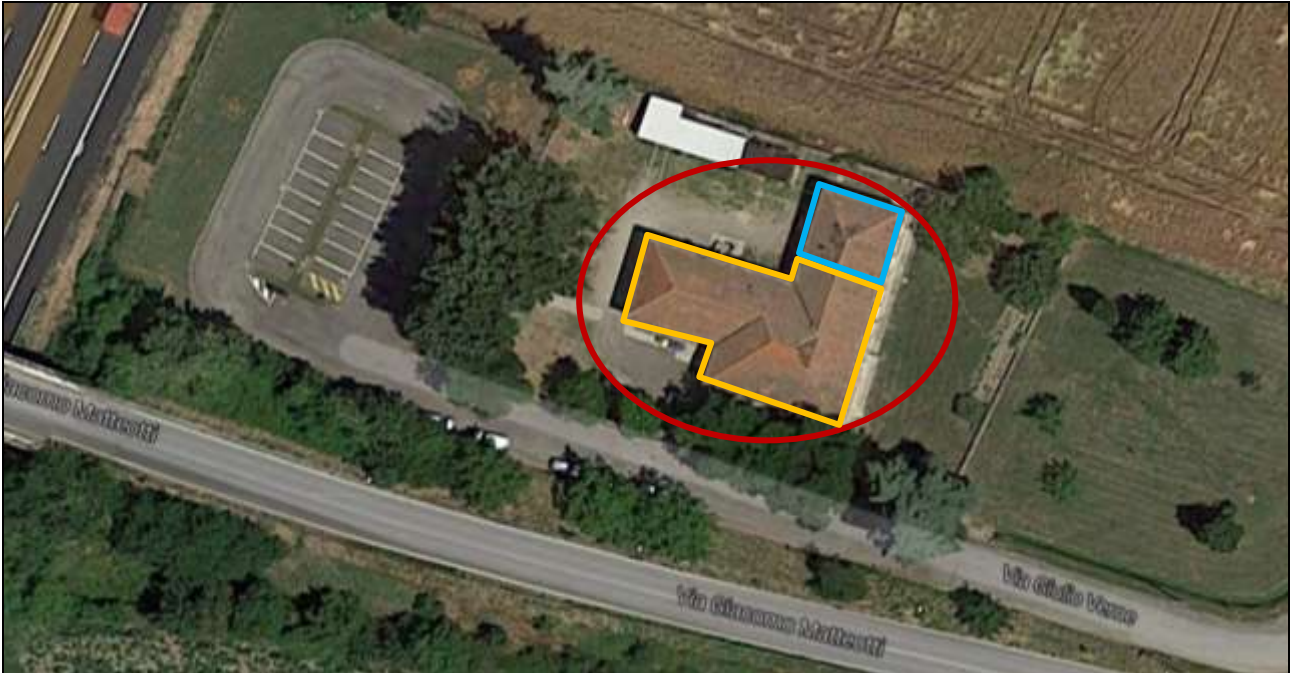
IMM01_ ortofoto fabbricato interessato dall'intervento (in rosso); in arancione l'unità ad uso scolastico, in azzurro l'unità ad uso residenza del custode.
