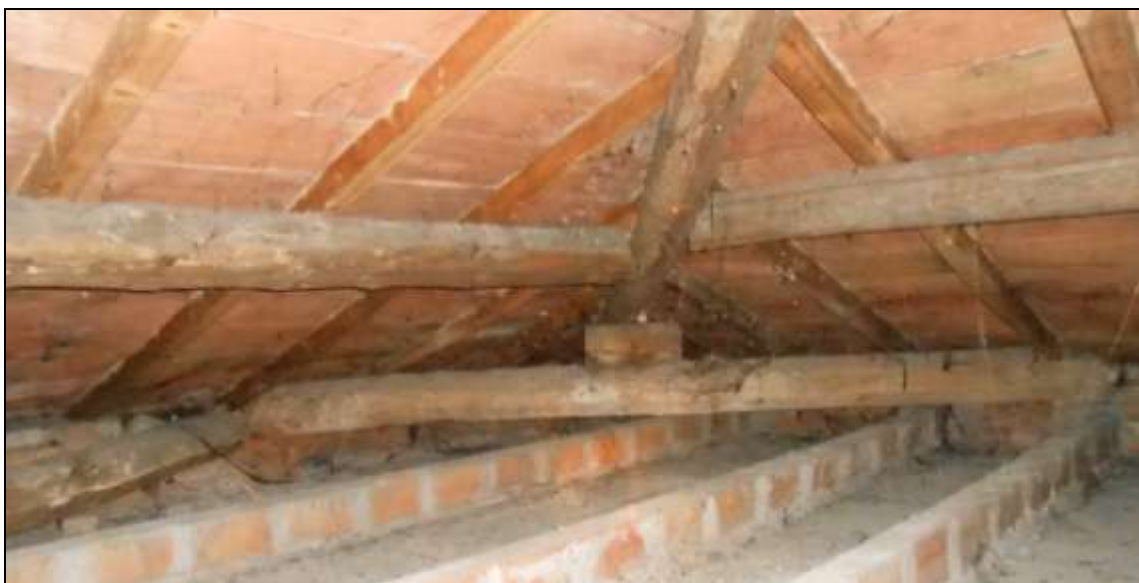
IMM07_foto sottotetto: particolare del cantonale.
