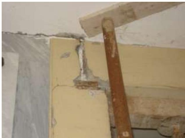
**Foto 01**\_si nota la presenza dello strato di polistirolo e la doppia piastra di appoggio del profilo in acciaio.
