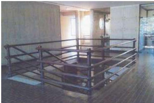
**Foto 01\_**"Blocco A", scala - parapetti da adeguare)
