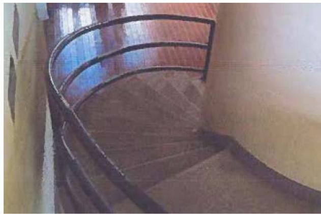
**Foto 02\_**"Blocco Canale", scala - parapetti da adeguare
