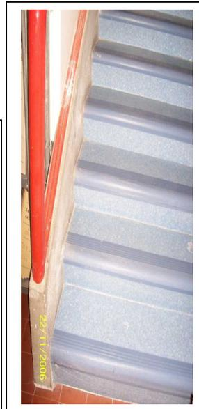
**Foto 1 e 2:** Rivestimento delle scale in gomma a bolli e in pvc da sostituire
